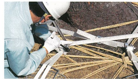
ウィンチ締め付け状況。
