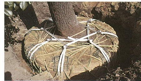
引き上げベルトを締め付け、「ちからパット」が変形して確実に根鉢を固定できれば完成。
