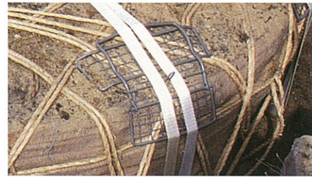
「ちからパット」が根鉢にフィットすると、根鉢上面を平均的に固定し、安定した力を発揮する。
