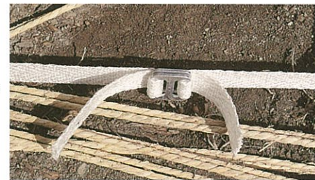
幹巻ベルトが、ねじれていないことを確認して、固定金具に正しく設置する。
