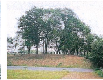
施工直後の状況。
