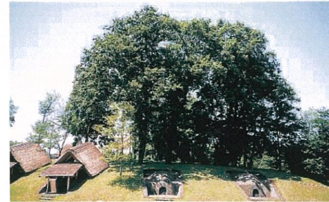
施工3年後の状況。
