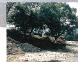
ブルドーザーによる土砂の嵩上げ。
