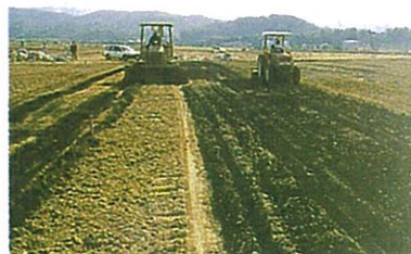
【写真-30】トラクターによる連続攪拌
