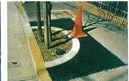
【写真-28】土壌改良後、再舗装
