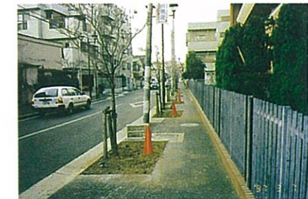
【写真-27】植マスを拡大し改良する。
