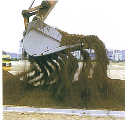
【写真-3】エコ炭の混合作業
