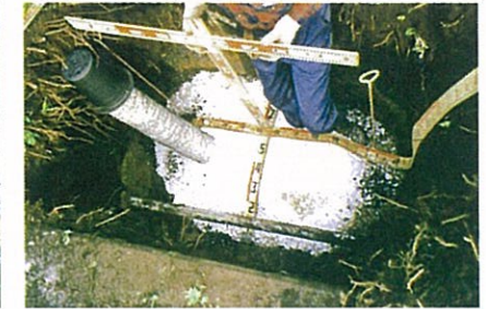
【写真-26】ホワイトローム底敷き+DOパイプ立ち上げ後、改良土を埋め戻す。
