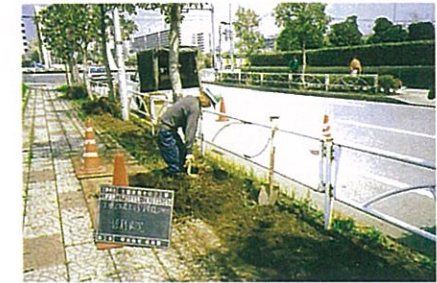
【写真-25】根の両脇を掘削
