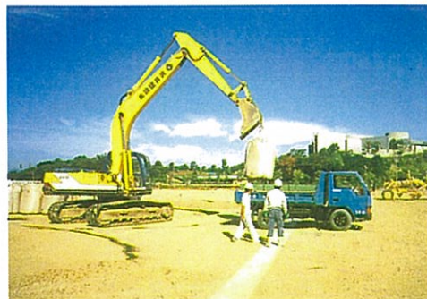
【写真-29】フレキシブルコンテナバッグでの搬入
