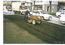
【写真-20】トラクターによる攪拌
