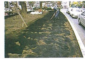
【写真-19】エコ炭散布、数均し
