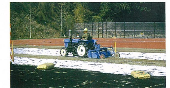
【写真-33】トラクターによる攪拌
