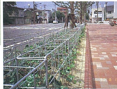
北九州市 若松区役所前植栽工事
