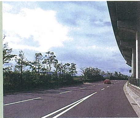
大阪府 中央環状線街路植栽工事
