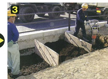
根系伸長域にパワーミックスを一層20cm厚みで投入し、タンバにて転圧を加える。
