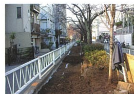
2.歩道部分にパワーミックスを施工。
