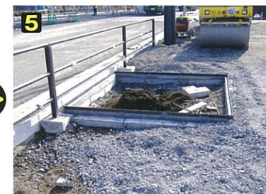
緑化蓋用基礎と外枠を施工して、路盤(RC)を転圧。
