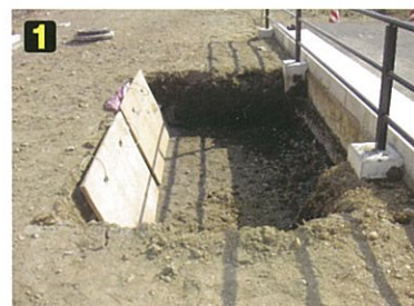
路床部分に生育用基盤槽を掘る。
