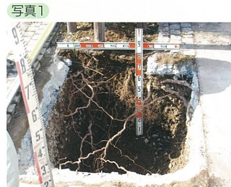
施工9年後の根の伸長状況。
