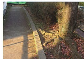
1.施工前の様子。
