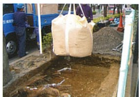
2.路床部を掘削し、パワーミックスを充填。
