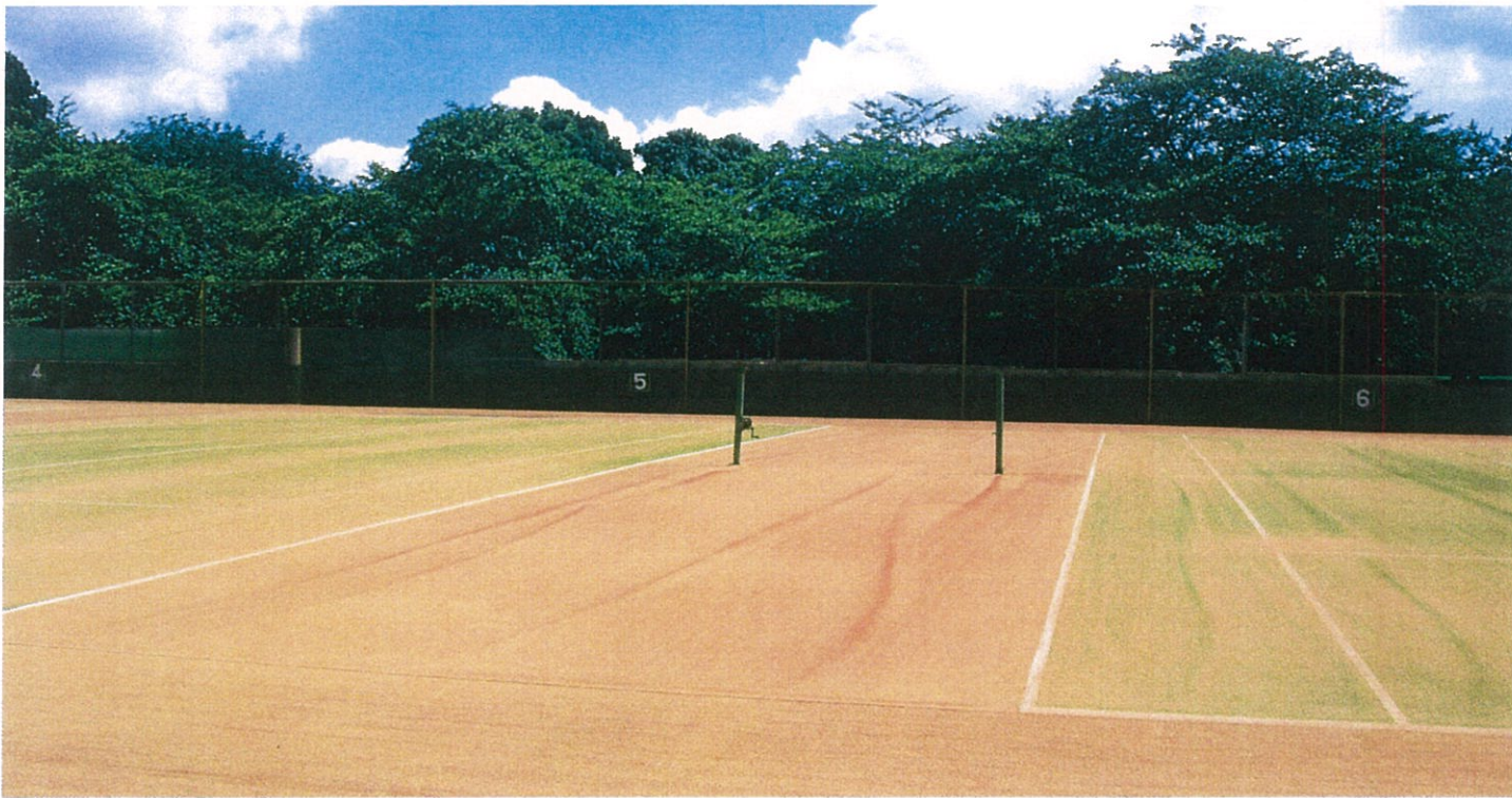
テニスコート目土砂散布完了
