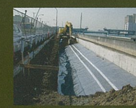
護岸整備の防根
