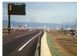
新東名連絡道路（静岡県長泉町）
