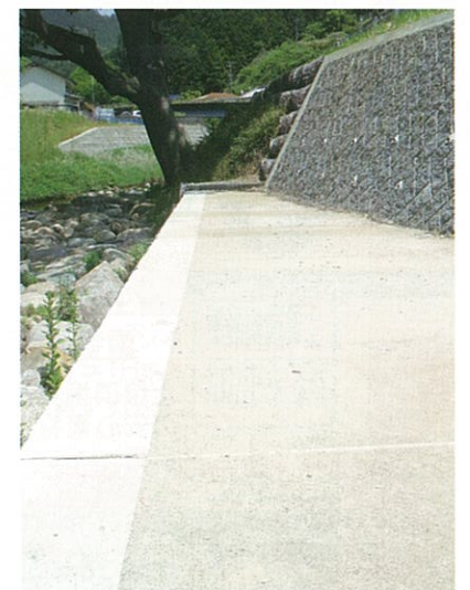
護岸道路 (愛知県新城市)
