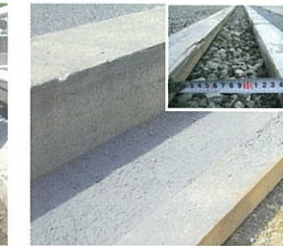
構造物(緑石ブロック等)から15cmの位置に型枠を設置します。
