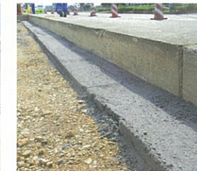
型枠を外し、完了です。
