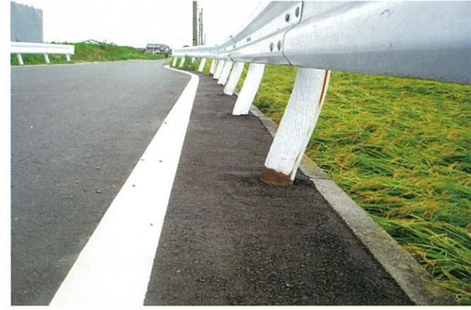
ガードレール下 表層工（アスファルト）完成（三重県鈴鹿市）
