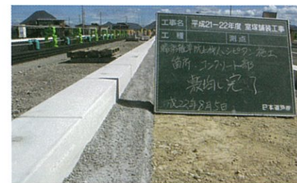
国道32号中央分離帯 ハシピタン敷設状況（香川県善通寺市）
