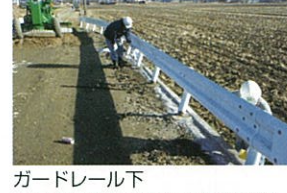
ガードレール下 ハシピタン敷設状況（三重県鈴鹿市）
