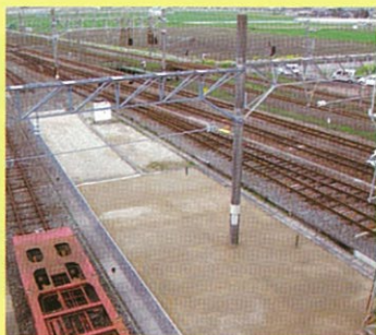
日本貨物鉄道（佐賀県佐賀市）
