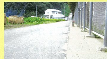
新幹線高架下ガンコマサ端部未施工 （広島県三原市）
