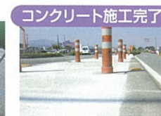
コンクリート施工完了
