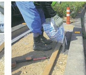
製品袋の下部にある「切り取り線」よりはさみでカットします。 型枠内(構造物端部)にハシピタンを出しませず。
