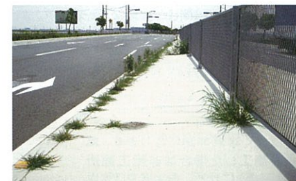
国道419号中央分離帯（愛知県刈谷市） ハシピタン未施工時
