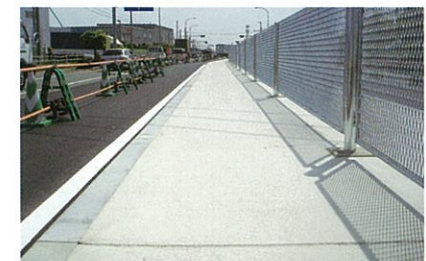
国道419号中央分離帯（愛知県刈谷市） ハシピタン施工後 コンクリート端部
