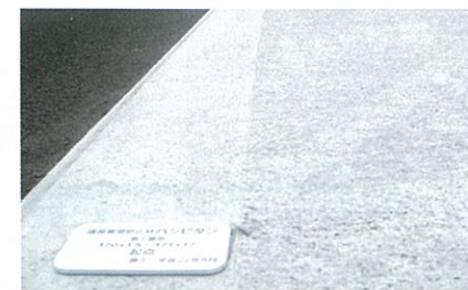
国道32号中央分離帯 表層工（コンクリート）完成（香川県善通寺市）
