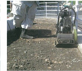
不陸修正を行い、転圧機にて十分に転圧を行います。
