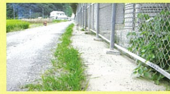
新幹線高架下ガンコマサ端部未施工 （広島県三原市）
