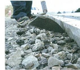
構造物(緑石ブロック等)際の路盤端部を約2cm掘り下げます。 ※雑草がある場合は、抜根作業を行います。
