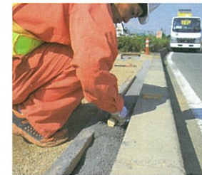
コチ等でハシピタンを均等に敷き均してください。 ※目安：巾15cm×延長5m×厚み15mm
