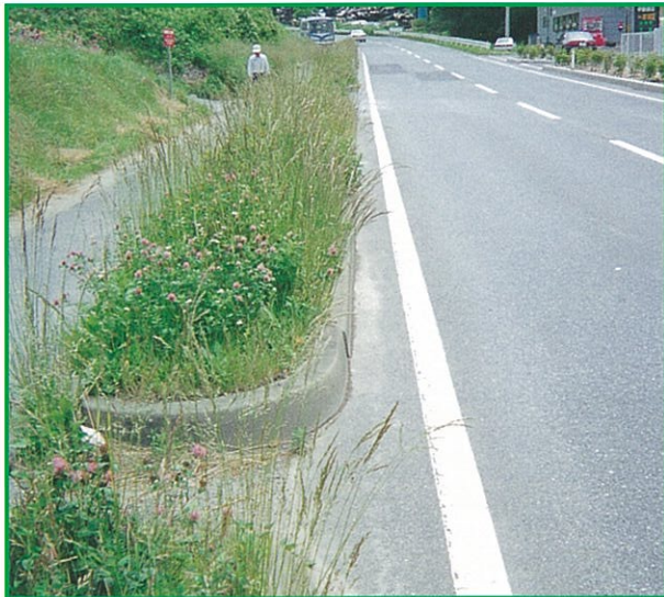
プランテックス®未施工
