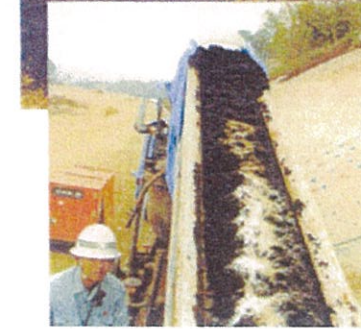
■ベルトコンベアー上での植生基盤材との混合。
