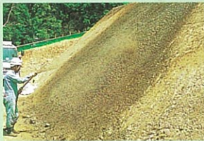
厚さ3cmネットなし吹付作業中。
