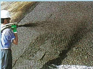
厚さ5cmで吹付。流出することがない。
