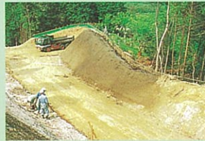
全体景 下50cmを吹付ないで作業。流出していない。
