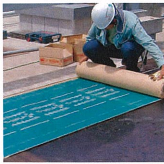
① 自着型耐根シートの設置 ※必要に応じて下地処理を行います。
