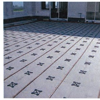
④ 灌水装置の設置
