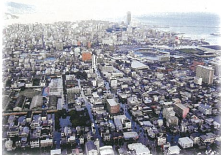
上空より高潮で冠水した高松市街地を望む (2004年8月31日撮影)
